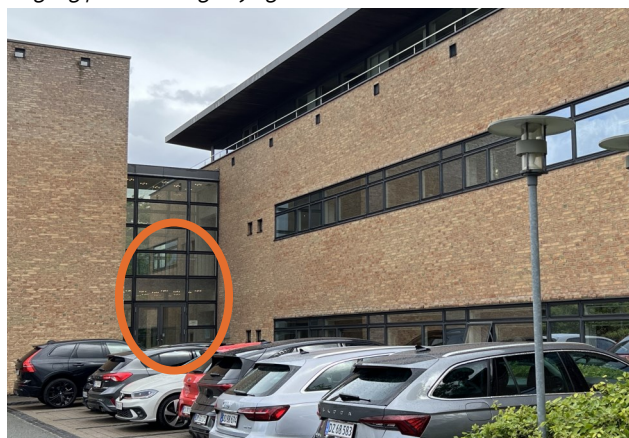
Adgang fra Christian X's Vej, parkeringsplads
